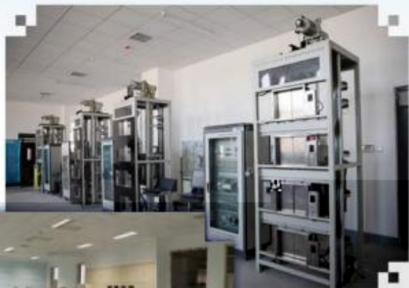
智能电梯安装调试 维护训练场所
